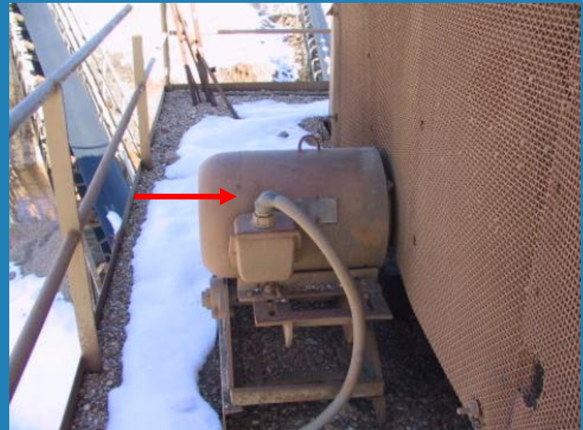
Broken, taped conduit
